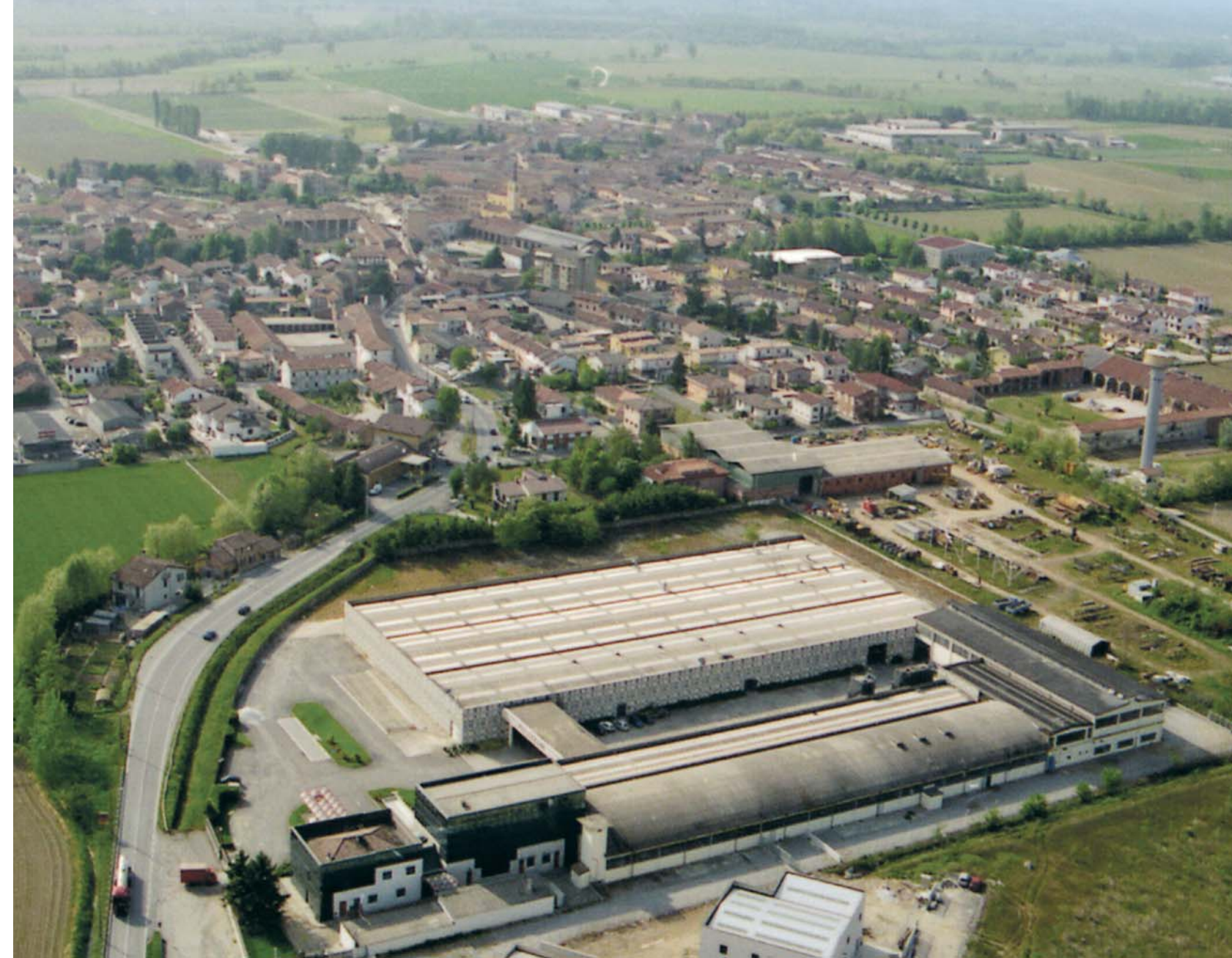
Sede della produzione e magazzino di Casalmorano, Cremona - Production headquarters and warehouse in Casalmorano, Cremona
